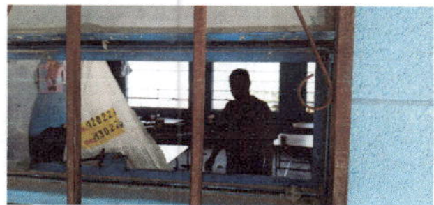
Foto 6: Sustitución Barandas de metal.
