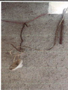
Foto 5: sustitucion de sistema electrico,
