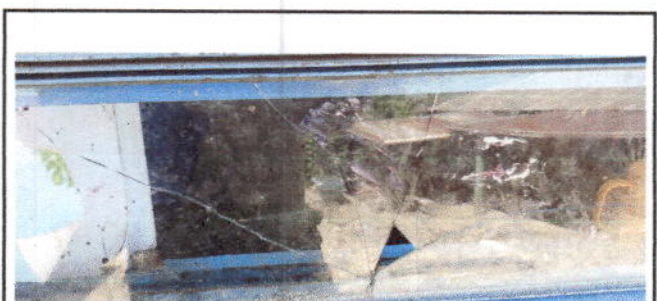
Foto 6: Sustitución Barandas de metal.
