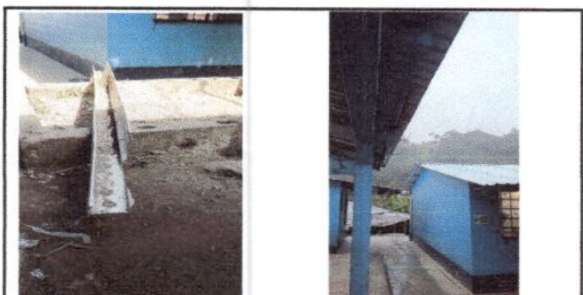
Foto 4: Reparación de canales
