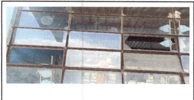
Foto 2: Sustitución de Vidrios.
