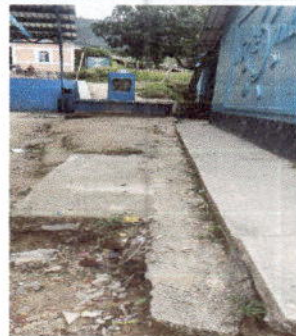
Foto 4: Reparacion de planchas de concreto de patio
