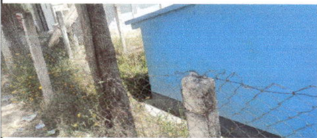
Foto 3: Reparacion de Malla galvanizada
