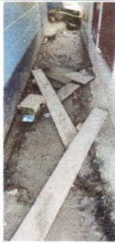
Foto1: para Instalación de tubería de aguas negras.
